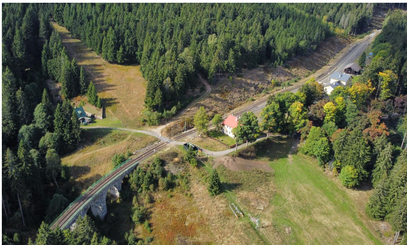
Pohled na železniční viadukt v současné době
